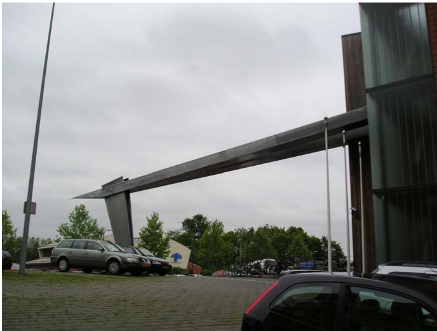
Open goot voor transport van regenwater van het dak naar het reservoir
