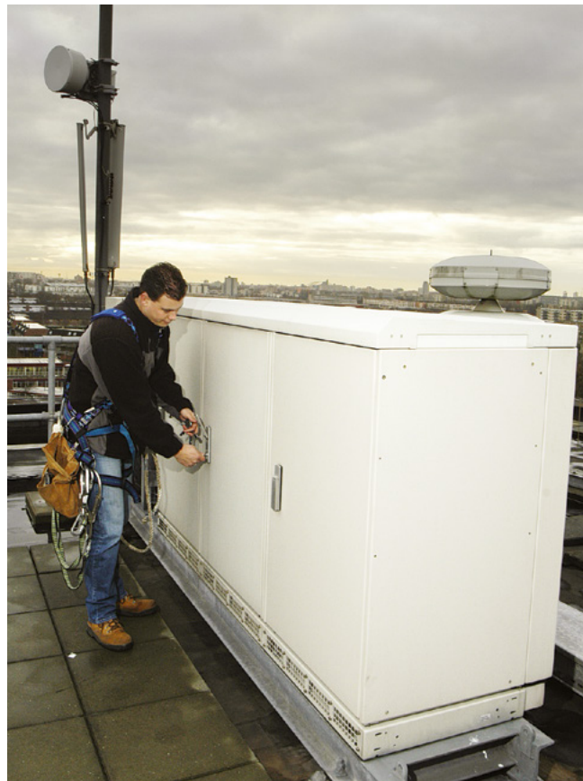
Dakwerker bij zendmast met straalzender en antennes voor mobiele communicatie
