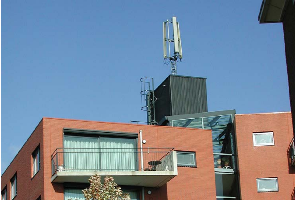
Figuur 1 Voorbeeld van een dakopstelling van een macrocellulair basisstation met drie GSM-antennes op één mast.
