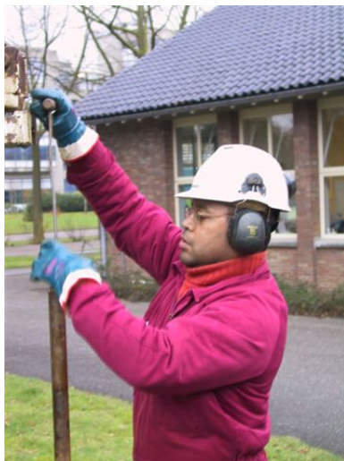
Figuur 8 Op positie houden van het filter via stangen
