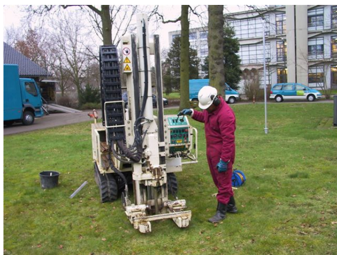
Figuur 7 Screenpointfilter wordt via de Geoprobe op diepte gebracht
