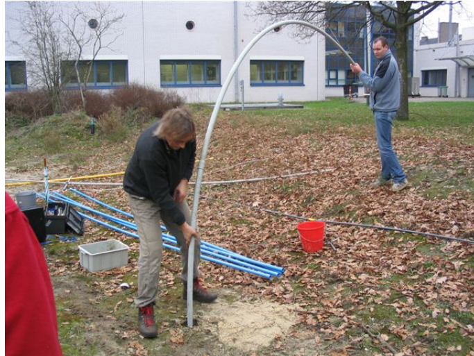
Figuur 10 Het plaatsen van de vijf meter lange Staay-buis
